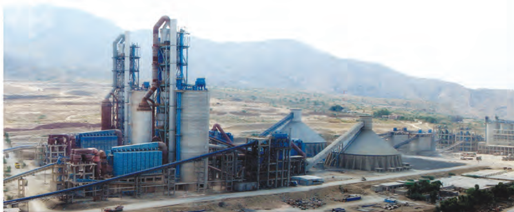
巴基斯坦Lucky水泥有限公司2 × 3000t/d熟料生产线 2 × 3000 t/d Clinker Production Lines at Lucky Cement Company Pakistan
