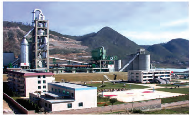
香港瑞安集团贵州顶效水泥有限公司1200t/d熟料生产线 Ruian Dingxiao Cement Corporation 1200t/d clinker production line
