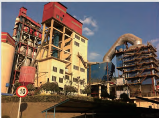
北方水泥德全汪清水泥有限公司4000t/d熟料水泥生产线
