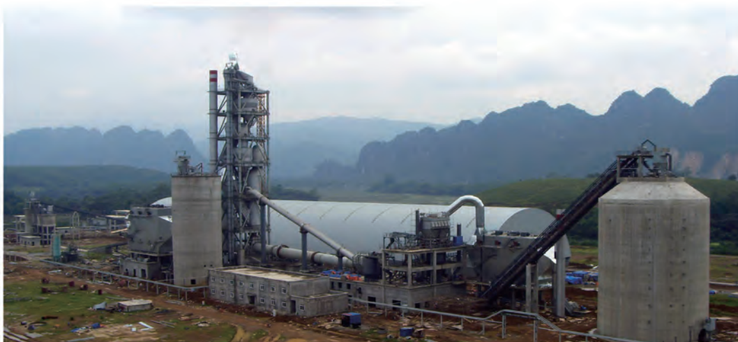
越南春梅水泥有限公司1500t/d熟料生产线 1500t/d Clinker Production Line at Xuan Mai Cement Company Limited Vietnam
