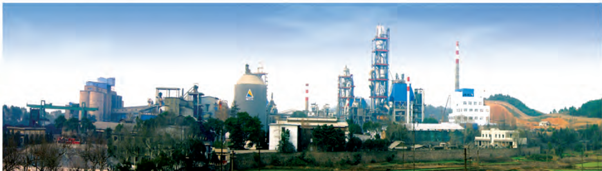
浙江江山水泥股份有限公司2500t/d熟料生产线 Jiangshan Cement Corporation 2500t/d clinker production line
