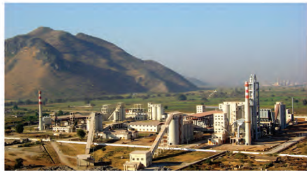
缅甸象王二水泥厂1000t/d熟料生产线 Myanmar Sin Min 02 Cement Factory 1000t/d Production line
