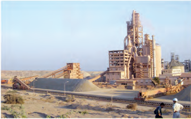
巴基斯坦ATTOCK水泥有限公司3000t/d熟料生产线综合技改工程 Attock Cement Company 3000t/d Clinker Technical Conversion Production Line
