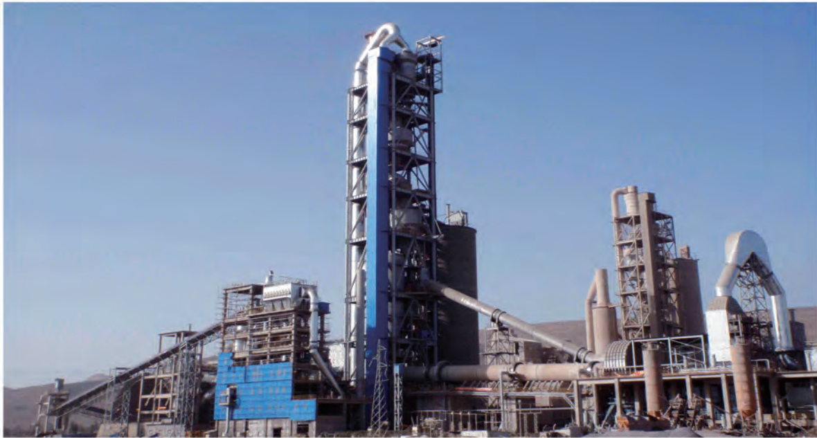
埃塞俄比亚Messebo水泥有限公司3000t/d熟料生产线 3000t/d Clinker Production Line at Messebo Cement Company Limited Ethiopia
