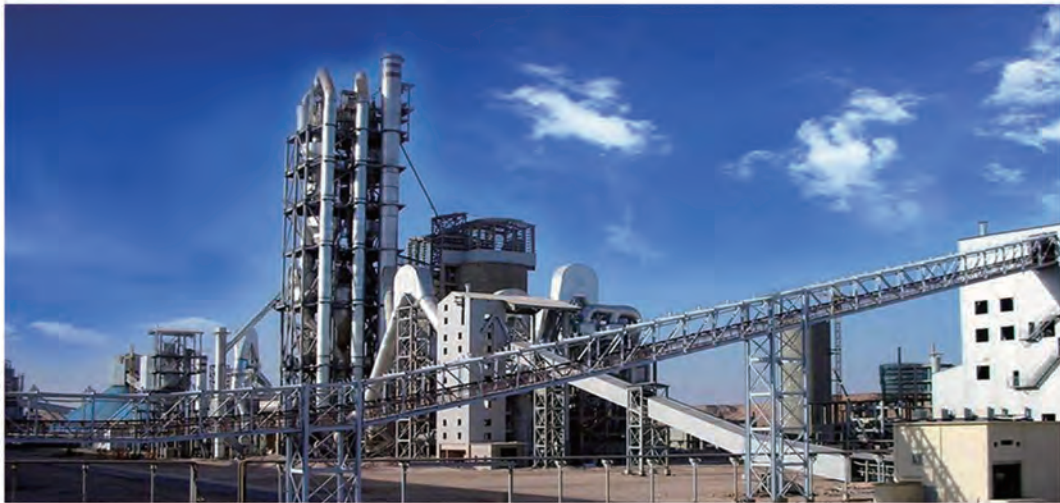
沙特阿拉伯Najran水泥有限公司6000t/d熟料生产线 6000 t/d Clinker Production Line at Najran Cement Co., Ltd. Saudi Arabia
