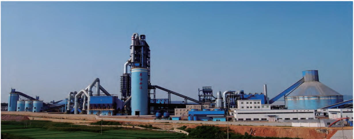
湖南益阳东方水泥公司5000 t/d熟料生产线 5000 t/d Clinker Production Line at Dongfang Cement Plant at Yiyang , Zhejiang
