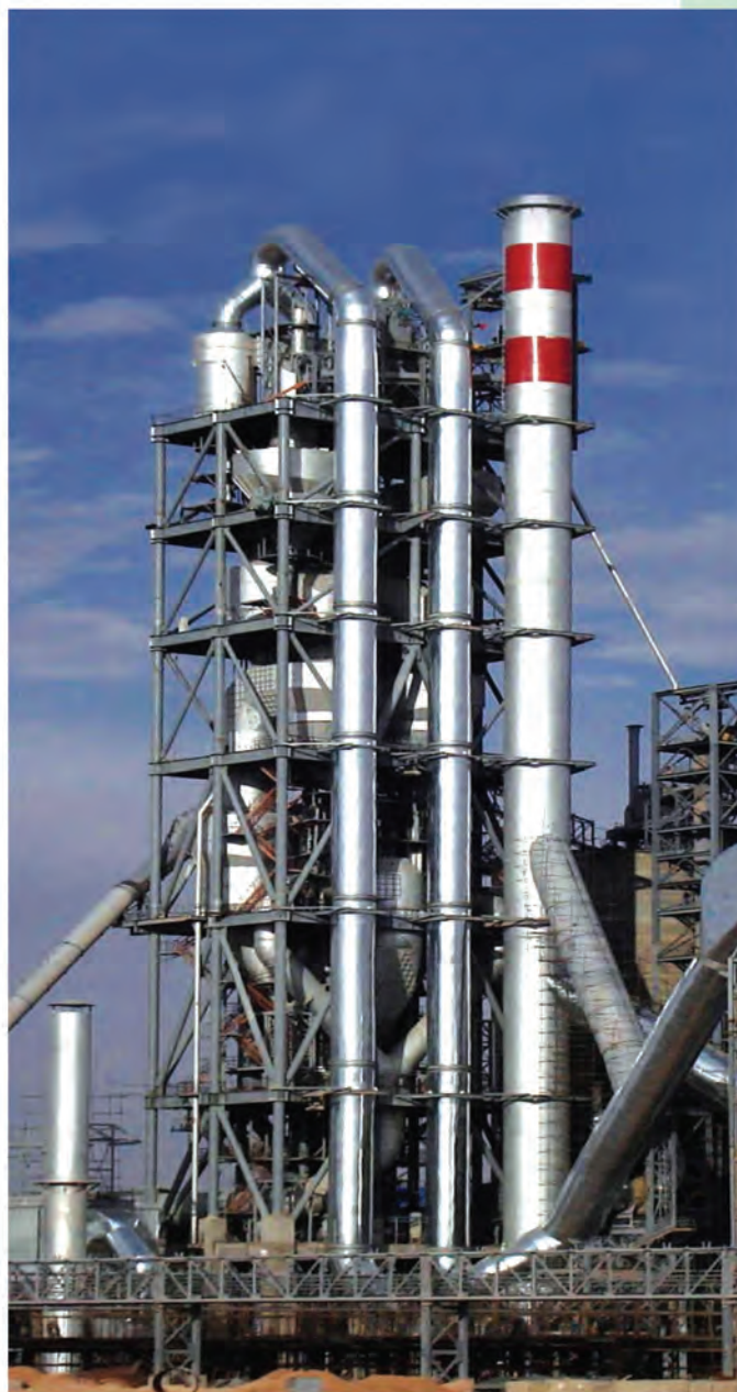
沙特阿拉伯北方水泥公司6000t/d熟料生产线预热器分解炉系统
