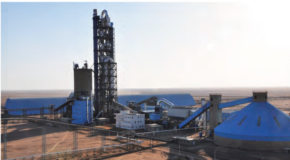
苏丹波波水泥公司5000t/d熟料生产线 5000 t/d Clinker Production Line at Ber Ber Cement Company Sudan
