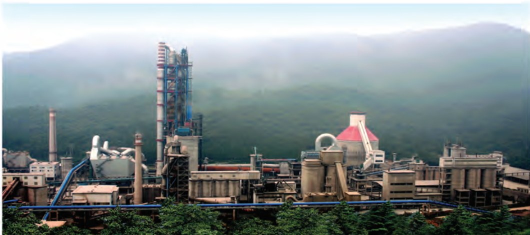
皖维高新材料股份有限公司6000t/d熟料生产线 6000 t/d Clinker Production Line at Wanwei High & New Materials Co., Ltd.
