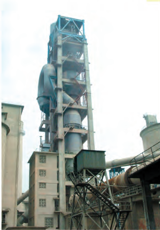
浙江尖峰集团金马水泥有限公司由 600t/d改造成1200t/d熟料生产线 600 t/d Converted to 1200 t/d Clinker Production Line at Jianfeng Group Jinma Cement Company Ltd.
