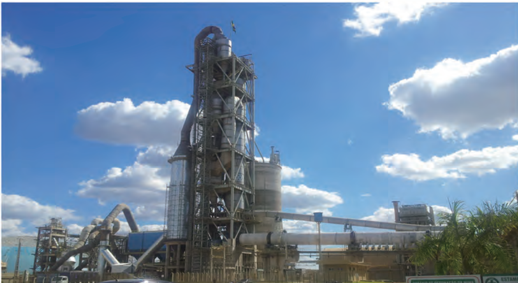
巴西 MZBA 水泥公司 3000t/d熟料生产线 3000t/d Clinker Production Line at MZBA Cement Plant Brazil
