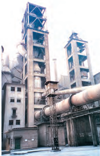
诸暨八方水泥有限责任公司由 600t/d改造成1200t/d熟料生产线 600 t/d converted to 1200 t/d clinker production line at Zhuji Bafang Cement Company Ltd.
