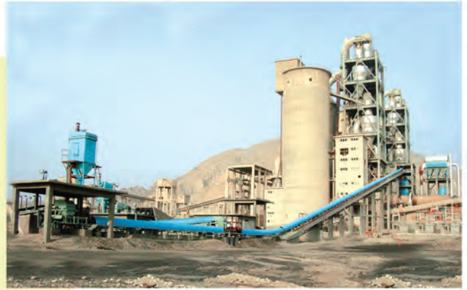
巴基斯坦Lucky水泥有限公司2500t/d熟料生产线油改煤技改工程 Oil to Coal Conversion Project of 2500 t/d Clinker Production Line at Lucky Cement Company Pakistan
