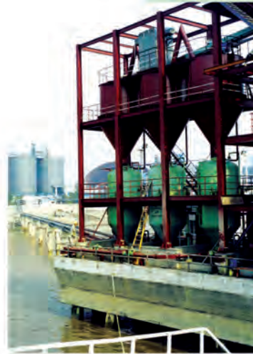
用于温州中山水泥股份有限公司 低速高浓度气力输送泵 (DB泵)，120t/h DB Pump, 120t/h, Used on Wenzhou Zhongshan Cement Share Holding Company
